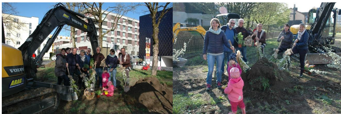
Fotos vom Spatenstich am 9. April 2019
